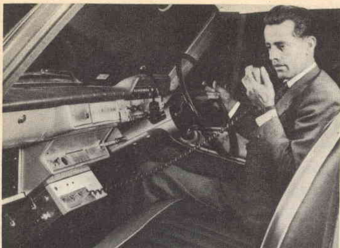
Apparecchiatura radiotelefonica inglese montata a sinistra del cruscotto di un'auto; la casa costruttrice è la Pye Telecommunications Ltd.
